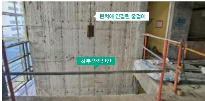
상부 안전난간이 제거된 모습
